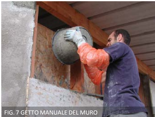
FIG. 7 GETTO MANUALE DEL MURO
