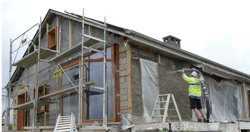
FIG. 4 APPLICAZIONE DEL CALCECANAPULO A SPRUZZO A UNA PARETE IN BLOCCHI IN CALCECANAPULO
