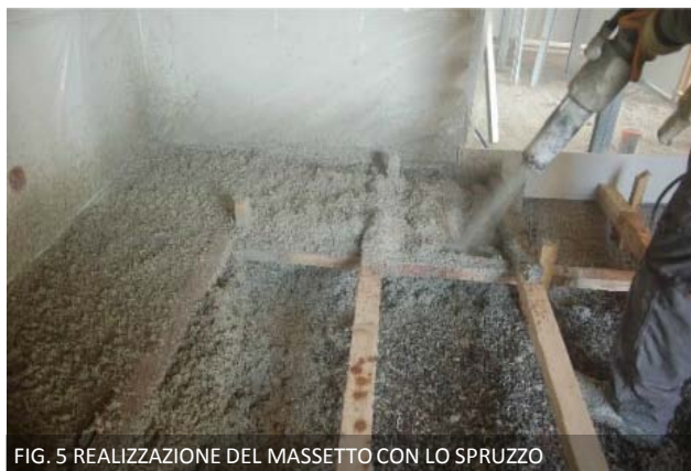
FIG. 5 REALIZZAZIONE DEL MASSETTO CON LO SPRUZZO
