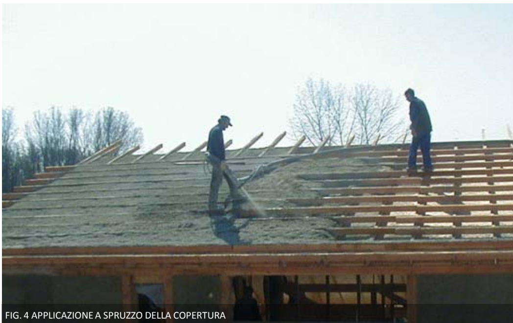
FIG. 2 APPLICAZIONE A SPRUZZO DELLA COPERTURA
