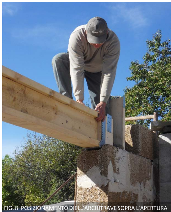
FIG. 8 POSIZIONAMENTO DELL'ARCHITRAVE SOPRA L'APERTURA
