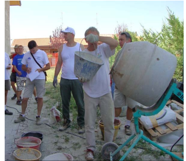
FIG.5 AGGIUNTA DEL CANAPULO E DELL'ACQUA RESTANTE
