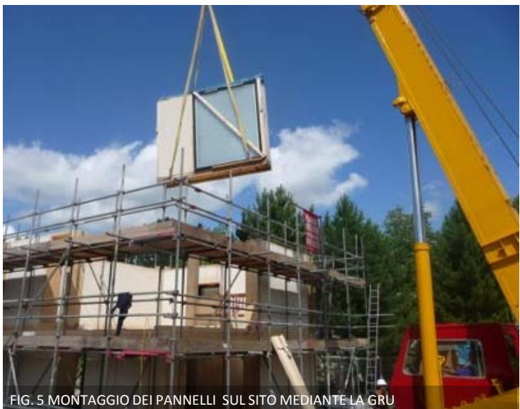
FIG. 5 MONTAGGIO DEI PANNELLI SUL SITO MEDIANTE LA GRU
