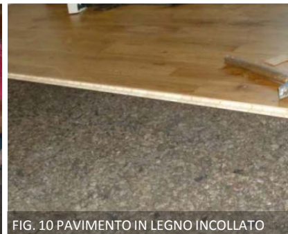
FIG. 10 PAVIMENTO IN LEGNO INCOLLATO
