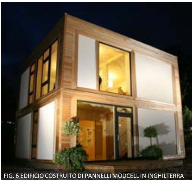
FIG. 6 EDIFICIO COSTRUITO DI PANNELLI MODCELL IN INGHILTERRA
