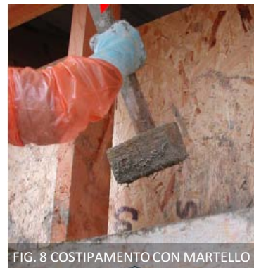
FIG. 8 COSTIPAMENTO CON MARTELLO
