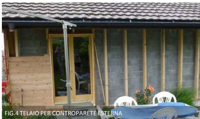
FIG.5 TELAIO PER CONTROPARETE ESTERNA
