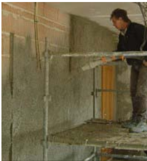
FIG. 5 SPRUZZO CONTRO UNA PARETE IN LATERIZI
