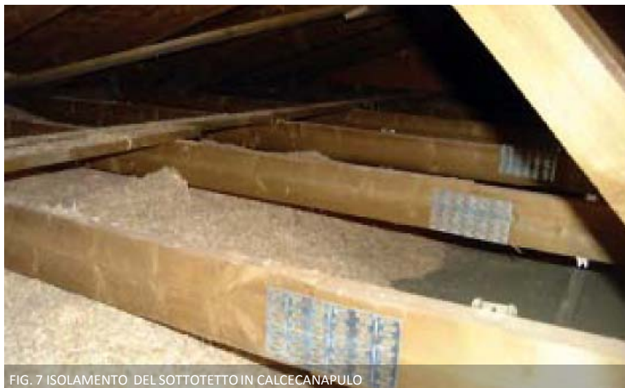
FIG. 7 ISOLAMENTO DEL SOTTOTETTO IN CALCECANAPULO
