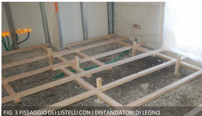
FIG. 3 FISSAGGIO DEI LISTELLI CON I DISTANZIATORI DI LEGNO
