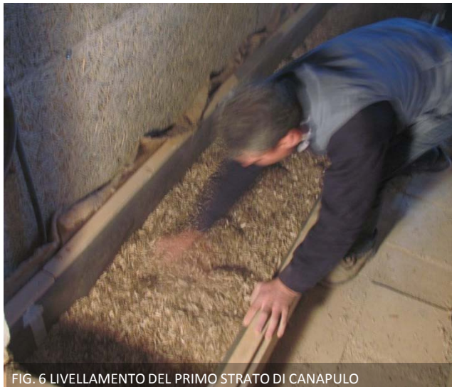
FIG. 6 LIVELLAMENTO DEL PRIMO STRATO DI CANAPULO
