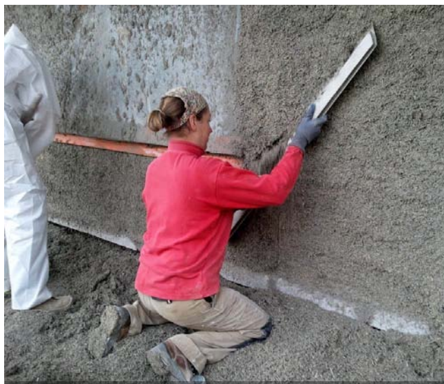
FIG. 5 LIVELLAMENTO DELLA SUPERFICIE CON UNA STAGGIA
