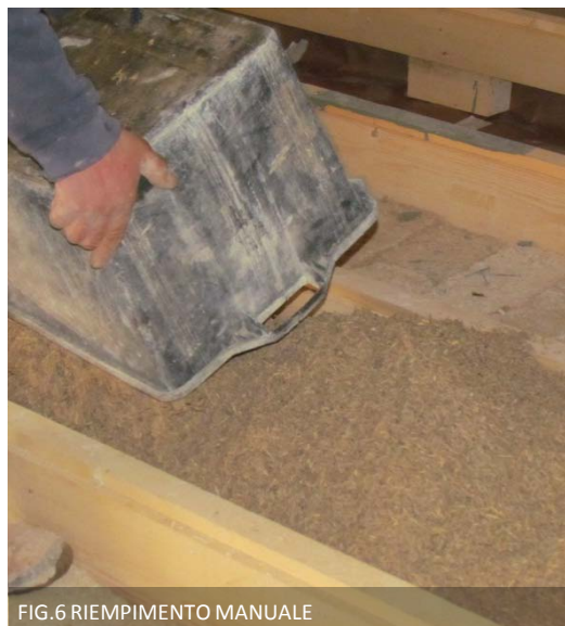
FIG.6 RIEMPIMENTO MANUALE
