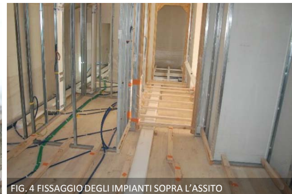
FIG. 4 FISSAGGIO DEGLI IMPIANTI SOPRA L'ASSITO
