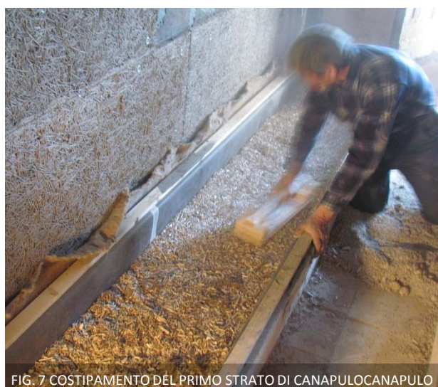
FIG. 7 COSTIPAMENTO DEL PRIMO STRATO DI CANAPULO
