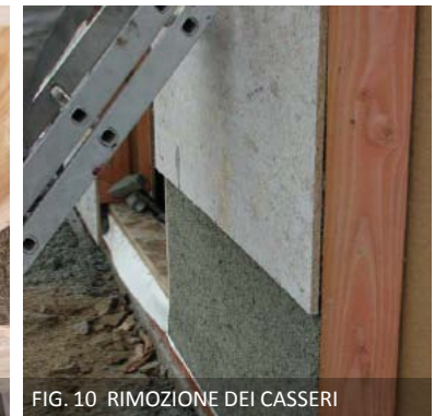
FIG. 10 RIMOZIONE DEI CASSERI
