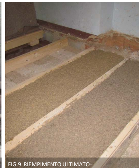
FIG.9 RIEMPIMENTO ULTIMATO
