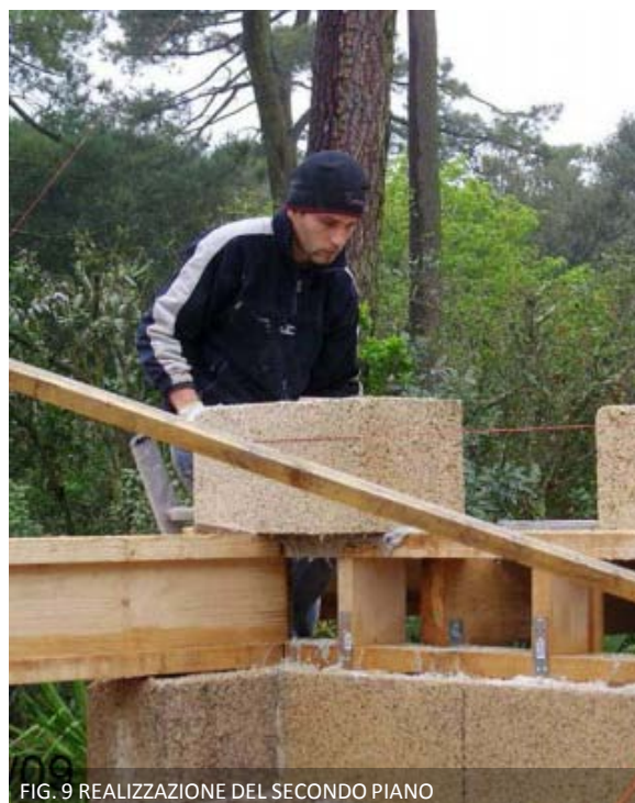
FIG. 9 REALIZZAZIONE DEL SECONDO PIANO
