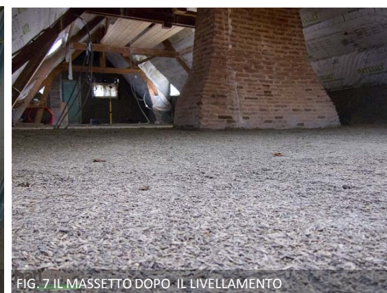
FIG. 7 IL MASSETTO DOPO IL LIVELLAMENTO
