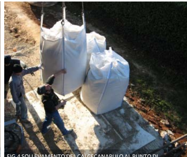
FIG.4 SOLLEVAMENTO DEL CALCECANAPULO AL PUNTO DI APPLICAZIONE
