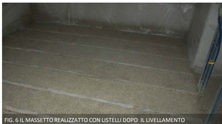
FIG. 6 IL MASSETTO REALIZZATO CON LISTELLI DOPO IL LIVELLAMENTO
