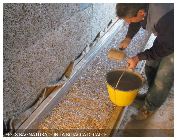
FIG. 8 BAGNATURA CON LA BOIACCA DI CALCE
