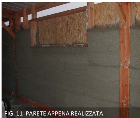
FIG. 11 PARETE APPENA REALIZZATA
